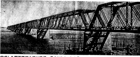
完成した関西鉄道木曾川鉄橋 長さ865メートル①
